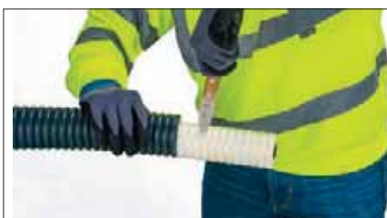
5 Tagliare/rimuovere l'isolamento per la lunghezza (X, Y, Z). Attenzione: non danneggiare il tubo di servizio!
