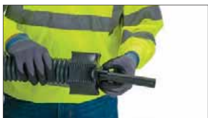
7 Termoretrarre con cura la chiusura dell'estremità del tubo secondo le istruzioni di montaggio accluse Raychem DHEC.
