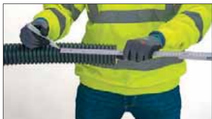
1 Contrassegnare la guaina alla distanza (x,y,z) +1 cm dalla estremità del tubo.
