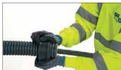
6 Montare l'anello passamuro.
