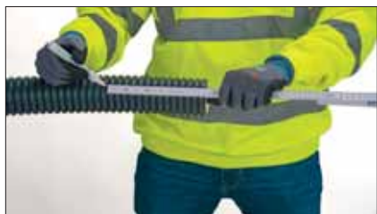
1 Contrassegnare la guaina alla distanza (x,y,z) +1 cm dalla estremità del tubo.
