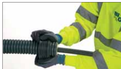
6 Montare l'anello passamuro.
