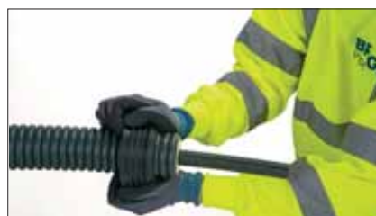
6 Montare l'anello passamuro.
