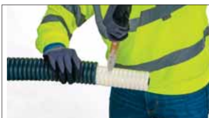
5 Couper/enlever l'isolation sur la longueur (x, y, z).
