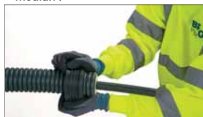
6 Monter le joint d'étanchéité mural.
