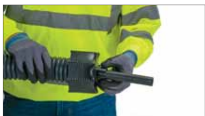
7 Procéder à la rétraction du capuchon d'extrémité CPX pour locaux humides, selon les instructions de montage Raychem-DHEC
