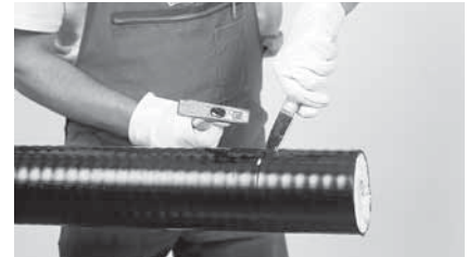
3 Découper le tronçon de gaine séparé longitudinalement. Introduire le couteau à une profondeur max. de 5 mm. Attention : Le tube median ne le fait pas blesser !
