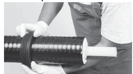
6 Monter le joint d'étanchéité mural.
