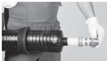
8 Glisser l'écrou d'accouplement et la bague de serrage sur le tuyau.
