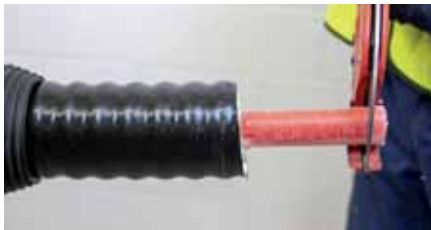
7. Falls erforderlich schneiden Sie die Rohrenden senkrecht nach.
