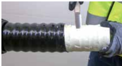
5. Dämmung über die Länge X/Y zurückschneiden. PEX-Rohr mit EVOH-Sperre nicht beschädigen!
