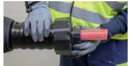
9. Schrumpfendkappe gemäss beiliegender Montageanleitung montieren.
