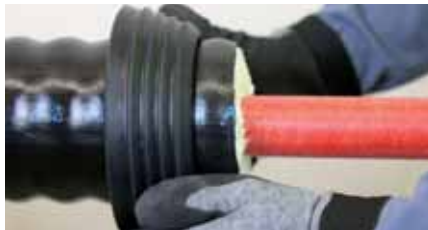
8. Mauerdichtring montieren.
