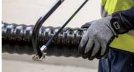
2. Mantel mit Säge am Umfang durchtrennen.
