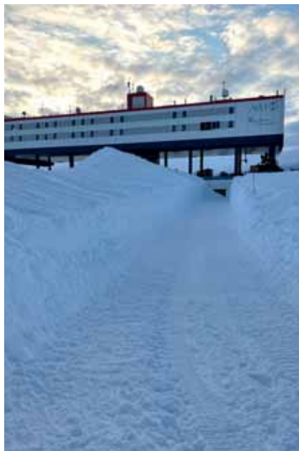
Wykop ze spadkiem jest wykończony, długość ok. 50 m
