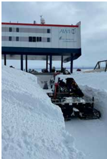
Scavando attraverso East Hills
