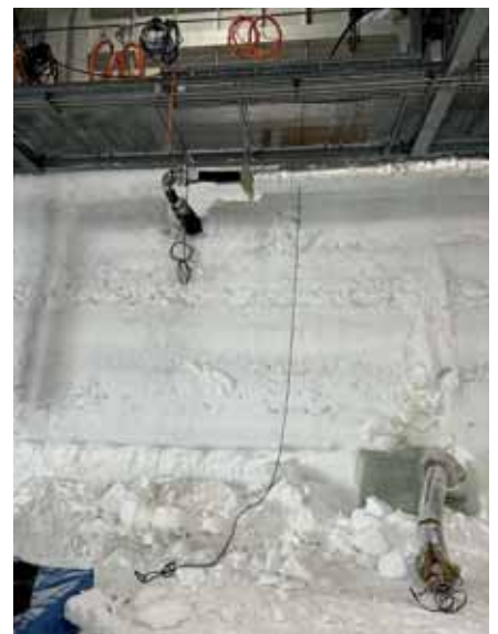
Vanha ja uusi putkilinja
