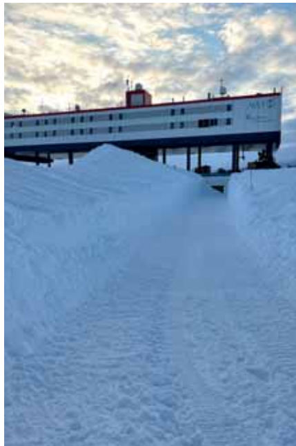
Rinteinen kaivanto on valmis, pituus n. 50 m
