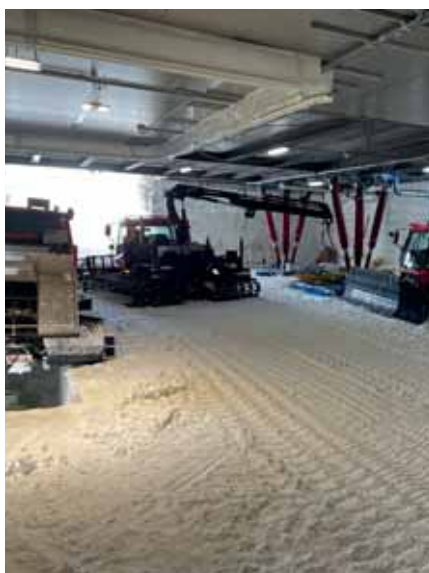
Rotzlerspil trækker rør fra tromlen
