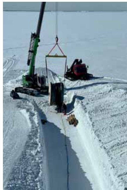
Oprulning på ydersiden med båndstrop
