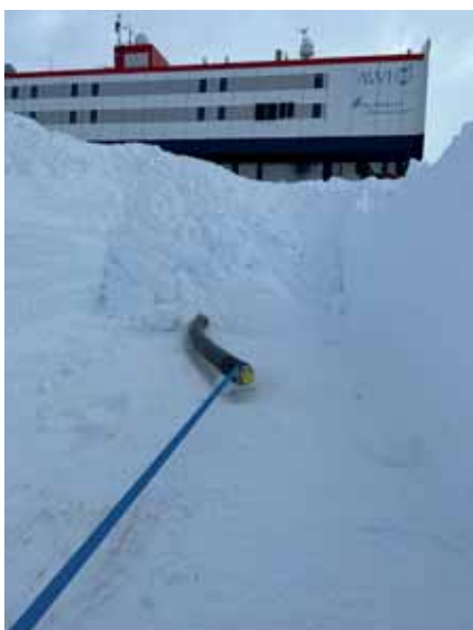
Hold røret midt i grøften
