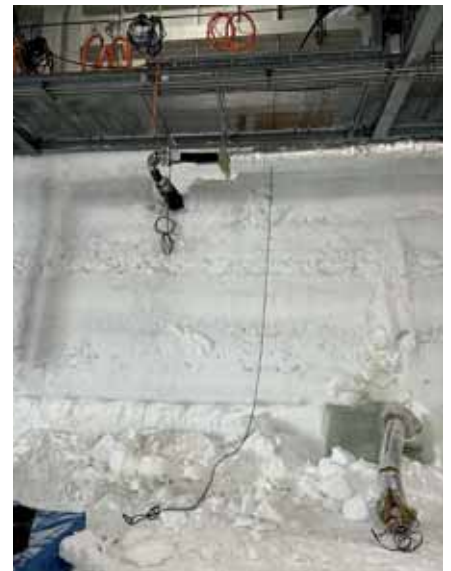
Alte und neue Leitung
