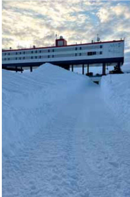
Graben mit Gefälle ist fertig, Länge ca. 50 m
