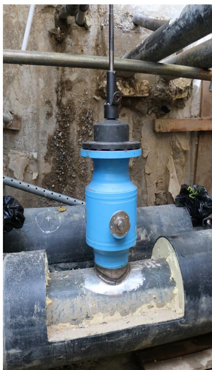
Grazie alla nostra tecnologia innovativa di perforazione, permettiamo un ampliamento semplice, sicuro e rapido dei sistemi di tubazioni esistenti. La nostra tecnica copre tutti i principali fornitori di manicotti per perforazione fino a DN 200 ed è perfettamente adatta a regolazioni flessibili delle reti.
