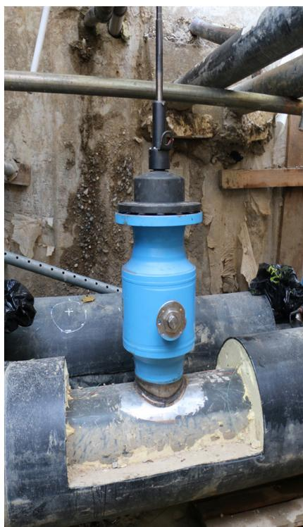
Grâce à notre technologie de forage innovante, nous rendons l'extension des systèmes de conduites existants simple, sûre et rapide.
